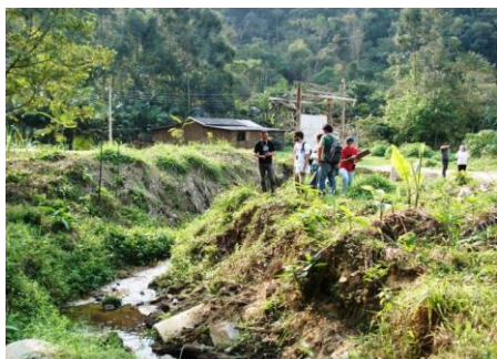
Figura 70: Margens em processo de erosão, causando assoreamento e ausência de mata ciliar.
