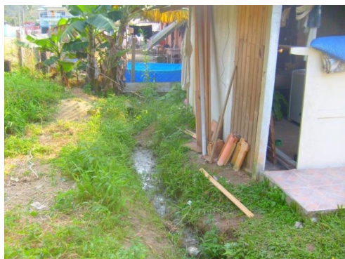
Figura 26: Vala que recebe a contribuição do esgoto in natura de oito residências.
