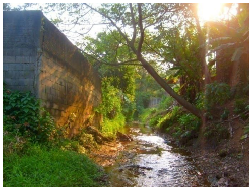
Figura 52: Construção de grande porte usando as pedras do leito do rio como fundação.
