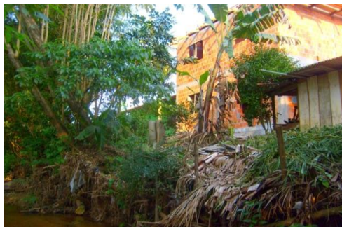
Figura 45: Construção na APP em andamento.
