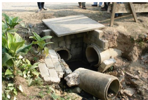
Figura 62: Equipamentos de drenagem e erosão.
