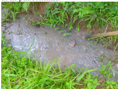
Figura 27: Detalhe do esgoto a céu aberto.
