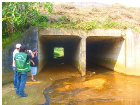
Figura 24: Verificação da passagem sob a BR 101, um dos pontos críticos da drenagem do bairro.
