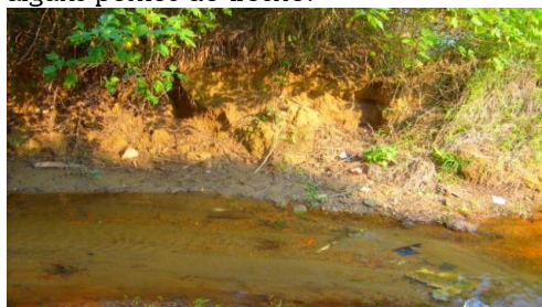
Figura 42: Processo erosivo que é intenso e onipresente nas margens do rio.
