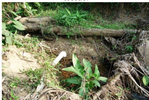
Figura 73: Esgoto sendo lançado no rio no momento em que a equipe visitava o local.
