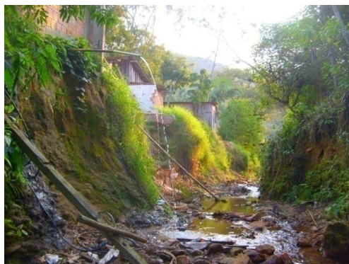
Figura 48: Casas em condições de risco de deslizamento.
